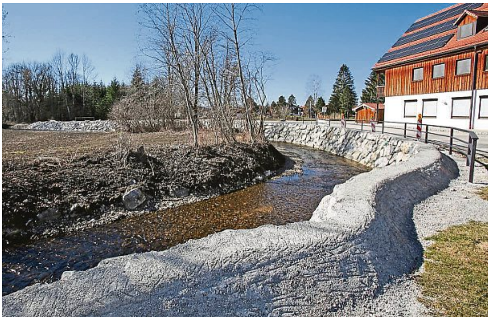
Auch am Gasthof Reindlschmiede wurde der Damm erhöht , so dass der Bach hier nicht mehr so schnell über die Ufer tritt. FOTO: PROHL
